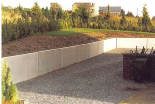
soutènement talus mur de jardin
