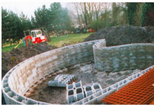
bassin fosse piscine
