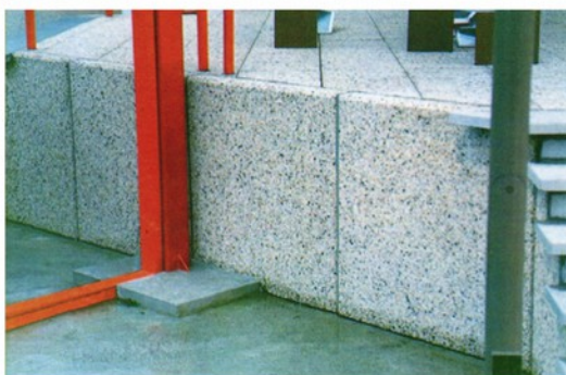
terrasse (calcaire lavé)
